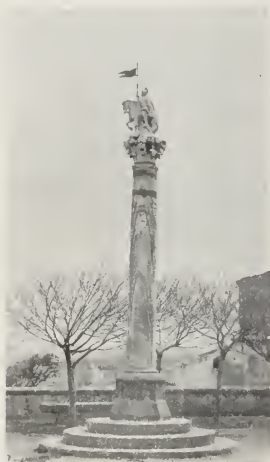
Portotorres - Chiesa di S. Gavino. Colonna nel piazzale.
